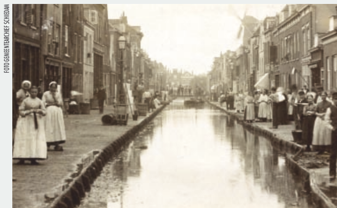
De gracht van het Broersveld in Schiedam diende als open riool, 1893.
